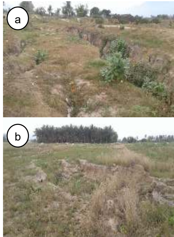
Gambar 4. (a) Tanah pertanian yang terbelah di Desa Jono Oge; (b) Permukaan tanah yang rusak dan ditumbuhi rumput dan ilalang di Desa Jono Oge.
